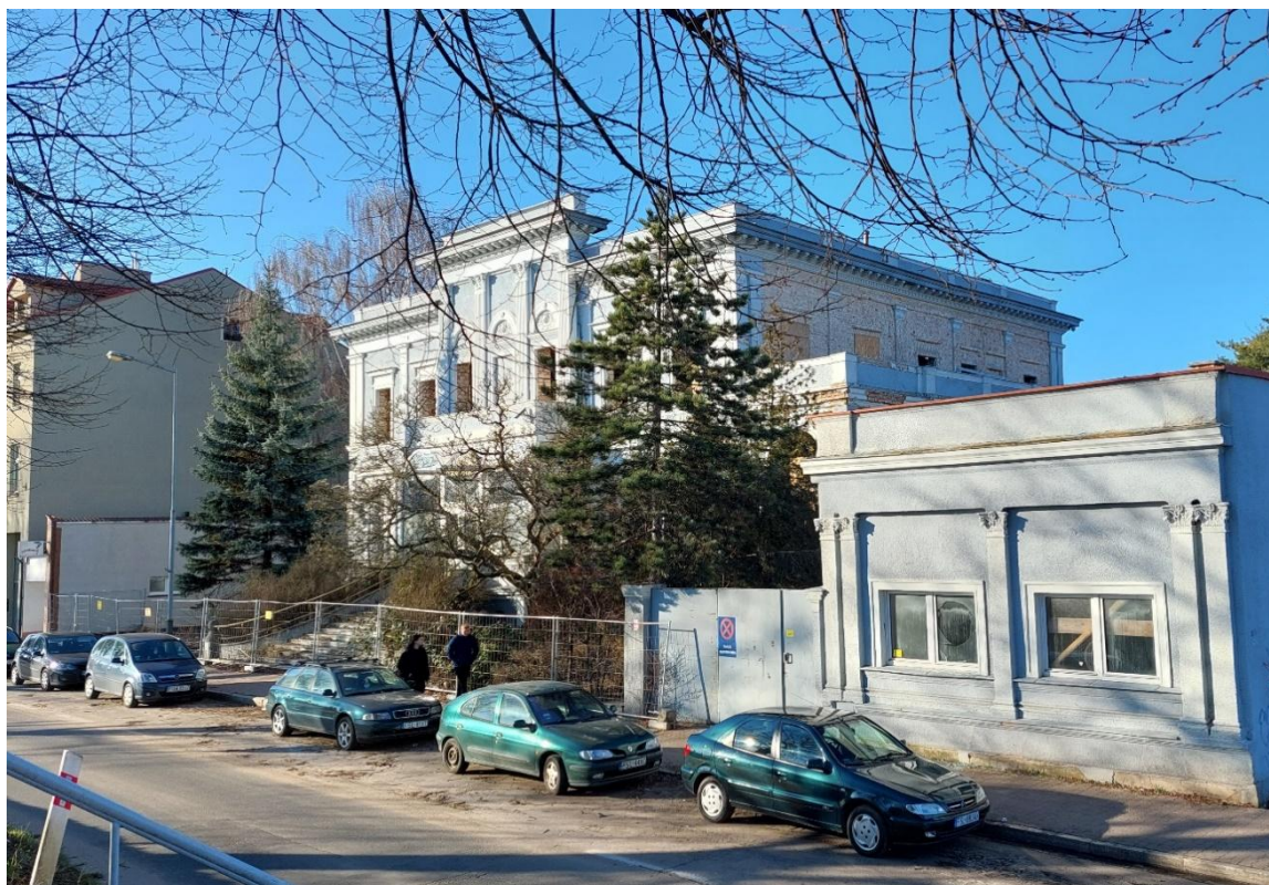
Ryc. 1 Widok budynku od strony ul. I Maja (A.M.)
