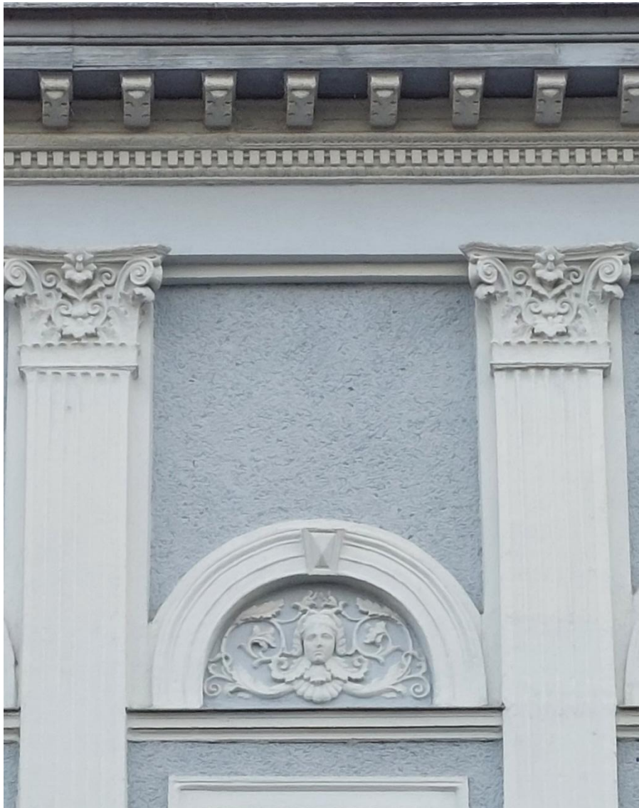
Ryc. 5 Zbliżenie groteski wypełniającej płycinę arkady, detalu głowic i kanelowanych (obecnie) trzonów pilastrów środkowego ryzalitu elewacji południowej (A.M.)
