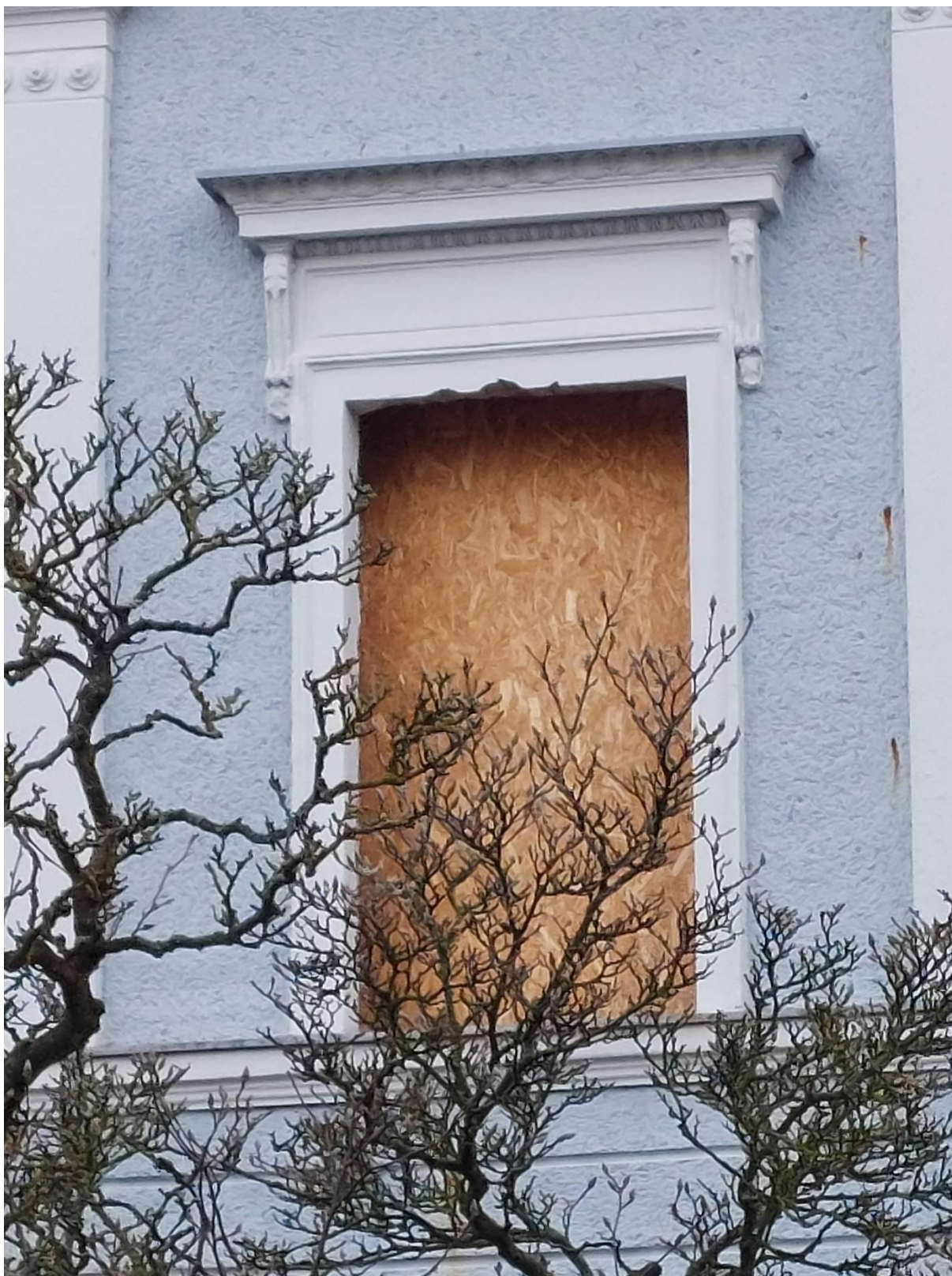
Ryc. 6 Zbliżenie obramienia okiennego drugiego piętra ze zdobionym motywem roślinnym naczółkiem wspartym na konsolach w formie esownicy (A.M.)
