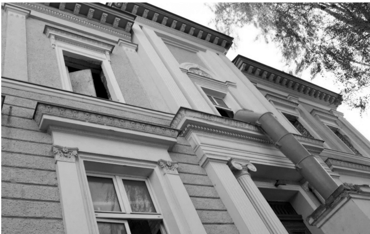
Ryc. 25 Zbliżenie detalu ściany zachodniej. Zwraca uwagę brak głowic pilastrów na poziomie drugiego piętra (R.S.)
