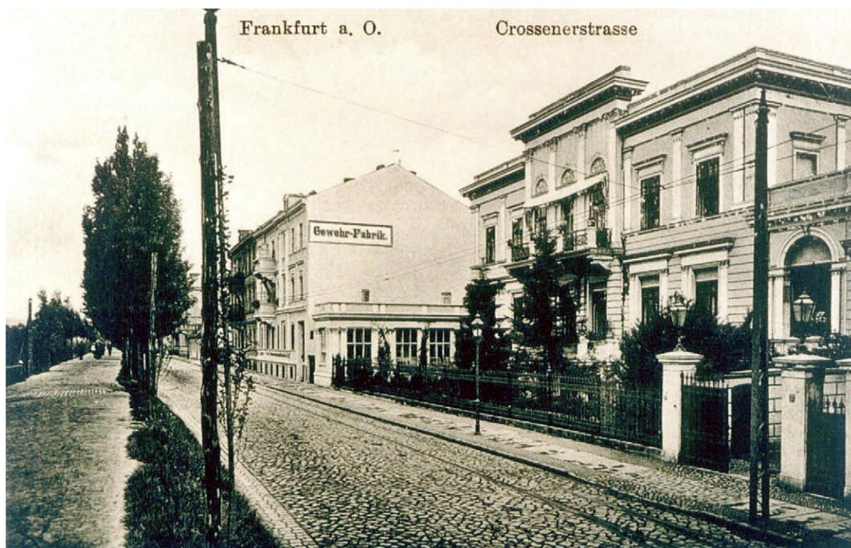
Ryc. 12 Stan budynku z okresu przełomu XIX - XX wieku. Widoczne są m.in. niezachowana oficyna zachodnia, kute ogrodzenie i brama od ulicy, balustrada balkonu w centralnym ryzalicie, jak również detal obramień okien drugiego piętra wschodniej elewacji. W skrzydle wschodnim pod tarasem pierwotne detale okna palladiańskiego (przypuszczalnie loggii). Ze zbiorów R.S.
