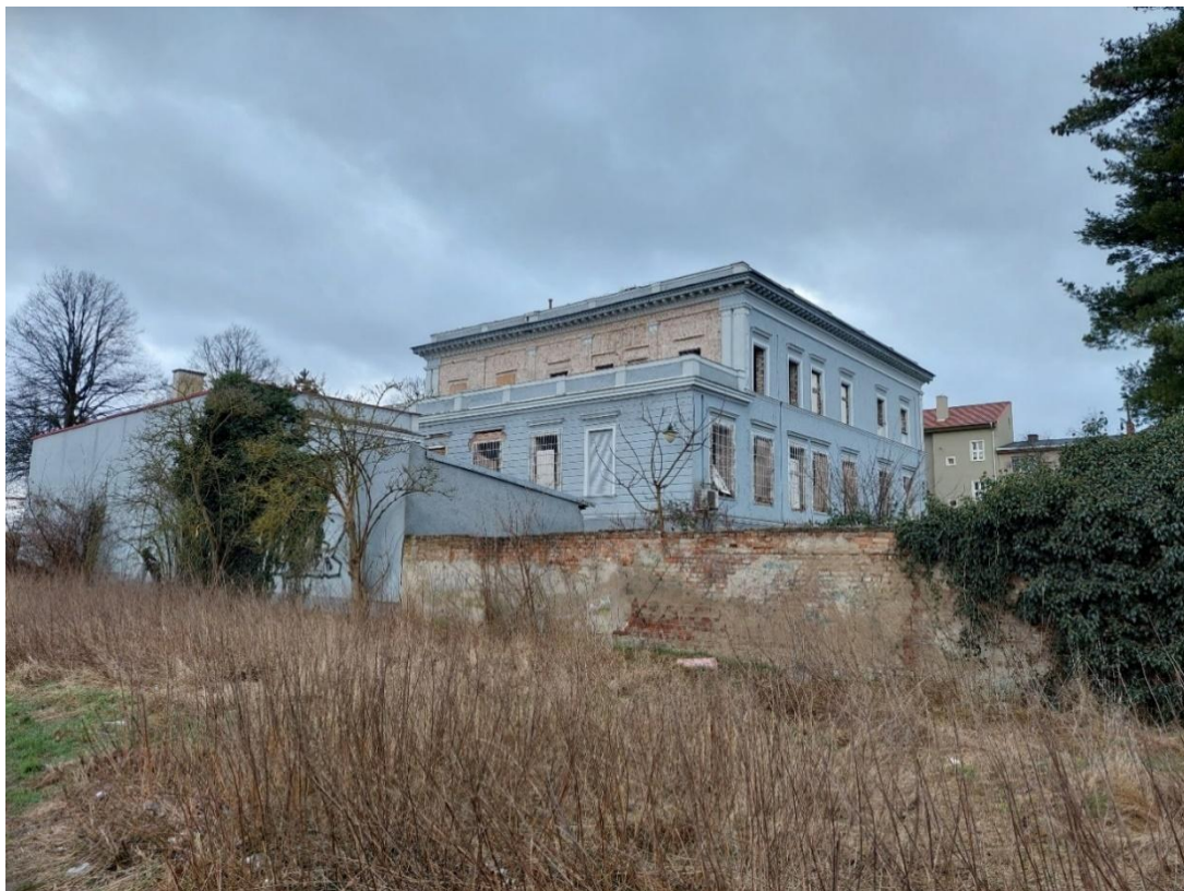
Ryc. 11 Elewacje: północna (ogrodowa) i wschodnia. Widoczne ponadto: oficyna wschodnia i taras drugiego piętra (A.M.)
