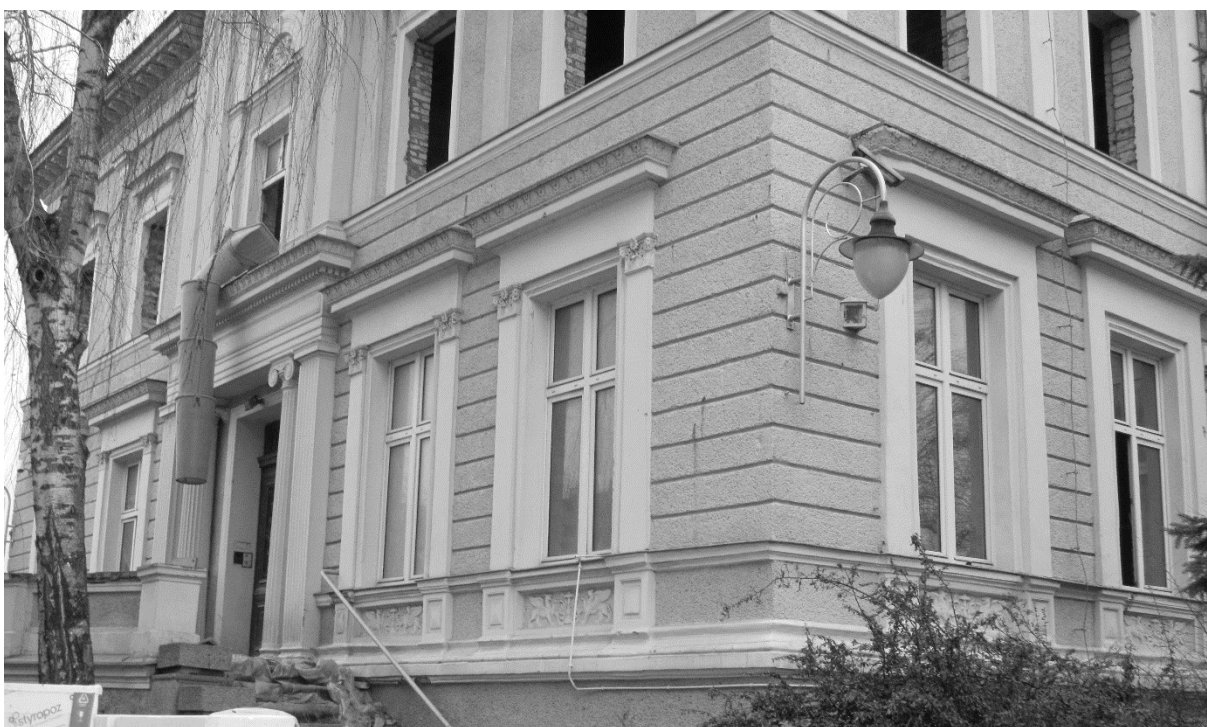
Ryc. 26 Porównanie detalu ściany zachodniej i południowej, w której częściowemu uproszczeniu uległy pilastry aediculi obramień okiennych na poziomie pierwszego piętra (A.M.)
