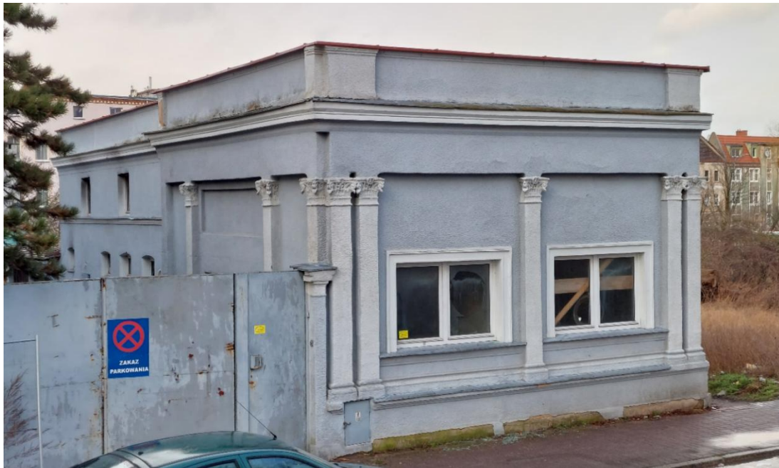
Ryc. 10 Zachowana oficyna od strony wschodniej. W elewacji można odczytać zarysy pierwotnych witryn (z zaoblonymi od góry narożami) znajdujących się pomiędzy pilastrami (A.M.)
