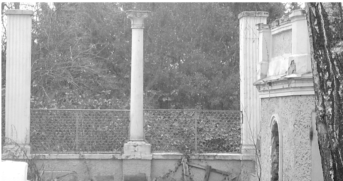
Ryc. 9 Zbliżenie pozostałości pergoli/trejażu(?) znajdujących się po zachodniej stronie budynku (A.M.)
