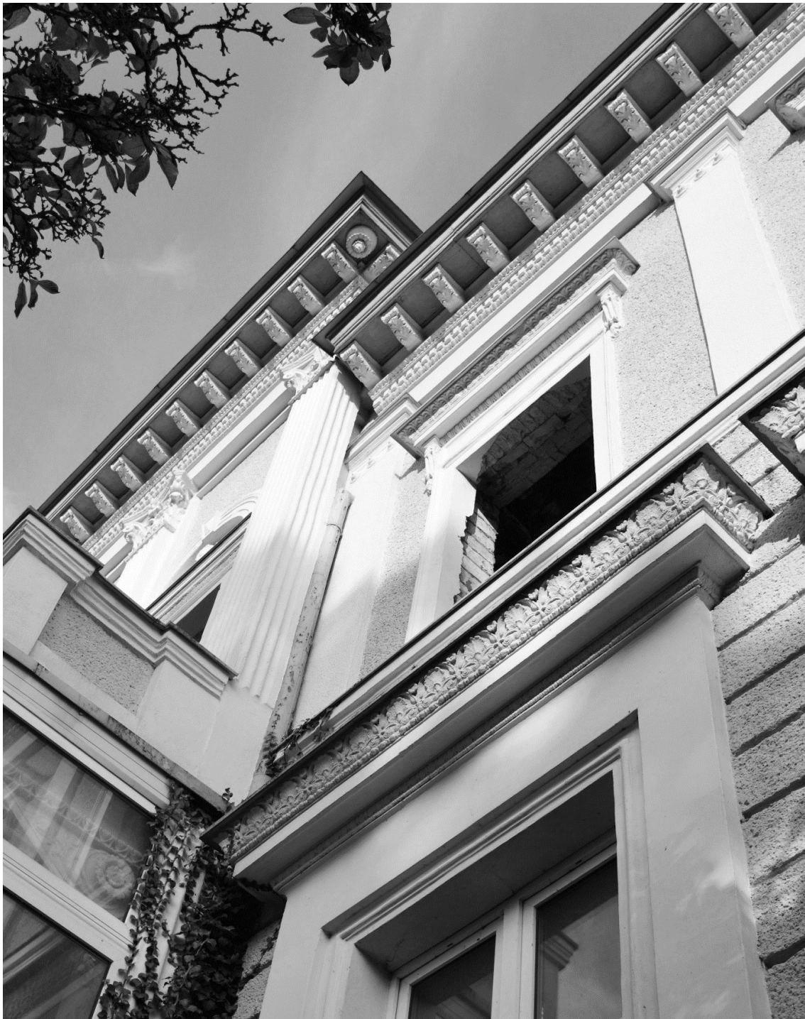
Ryc. 3 Zestawienie detalu południowej elewacji zewnętrznej. W partii gzymsu koronującego modylionowe kroksztyny z liśćmi akantu i narożne, podwieszane roślinne rozety (R.S.)
