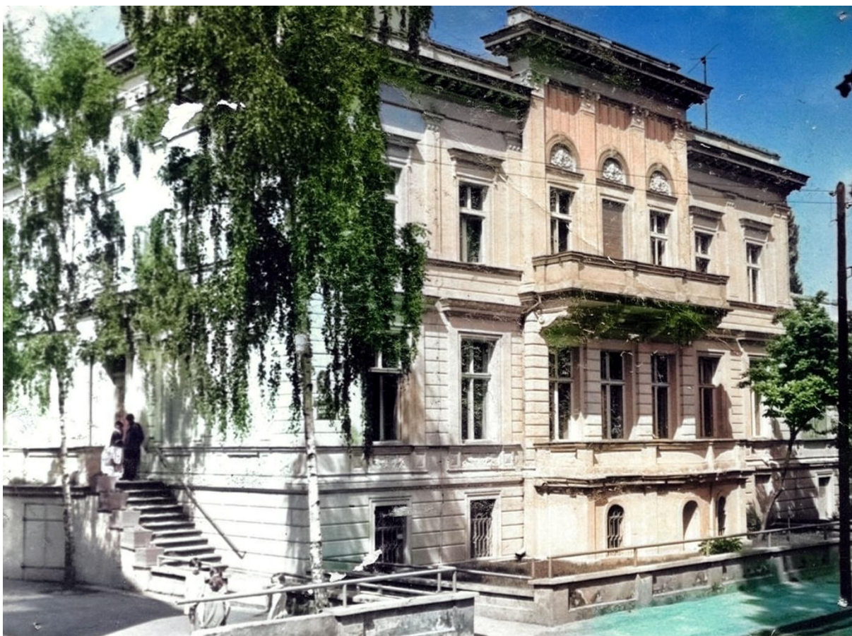
Ryc. 14 Stan obiektu na lata 60. XX wieku. Widoczne jest m.in. niezachowane obecnie boniowanie w przyziemiu i pionowe profile laskowania w polach pomiędzy pilastrami drugiego piętra ryzalitu. Zwraca uwagę brak kanelowania pilastrów ryzalitu frontowego i (przypuszczalna) obecność głowic na zwieńczeniu pseudoryzalitu na ścianie zachodniej. Zdjęcie prawdopodobnie wskazuje również pierwotną (lub częściowo zachowaną) kolorystykę elewacji. Ze zbiorów R.S.
