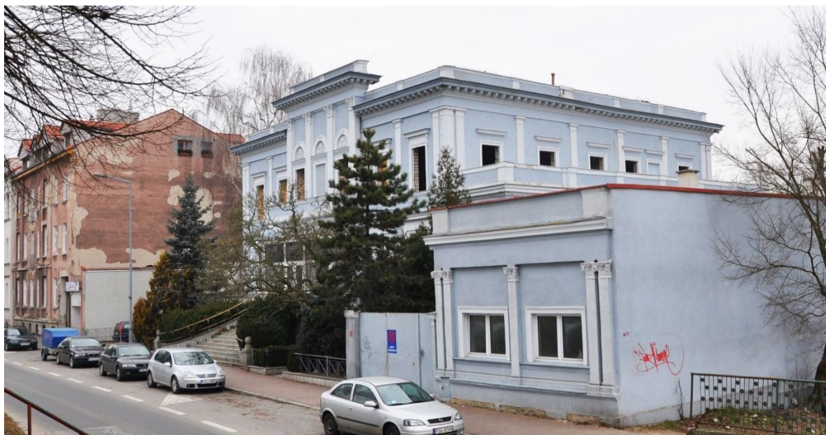
Ryc. 21 Widok wschodniej ściany drugiego piętra przed usunięciem naczółków i obramień okiennych. Źródło: https://zamikilubskie.pl/slubice-frankfurt-oder-dammvorstadt/ , dostęp 21.03.2022 r.
